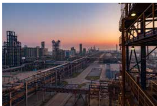
تضع مرافقنا المنتجة للببتروكيماويات حول العالم لحدود ومقاييس تضعها الحكومات بشأن الانبعاثات
